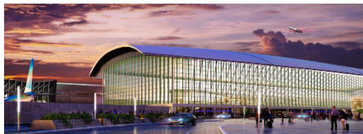
ra un muro cortina que funcionará como envoltura de todo su perímetro, apoyando sobre un dintel de hormigón armado. Sobre el gran espacio del hall se desarrollará una cubierta de estructura metálica, materializada en el interior con un cielo raso tensado y en el exterior con placas de aluminio con ar-
